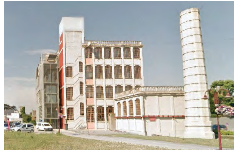
Afbeelding 9 Zicht op het administratief centrum Sanitary en stoomketelmuseum (Gustaaf Schockaertstraat)
