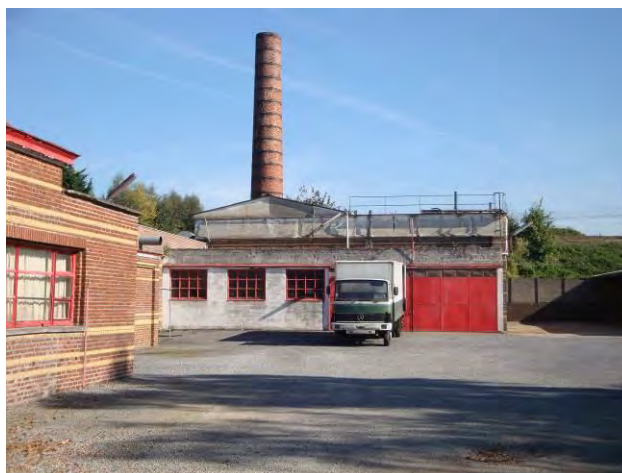
Afbeelding 20: Bedrijfsgebouwen Cantact (noord)
