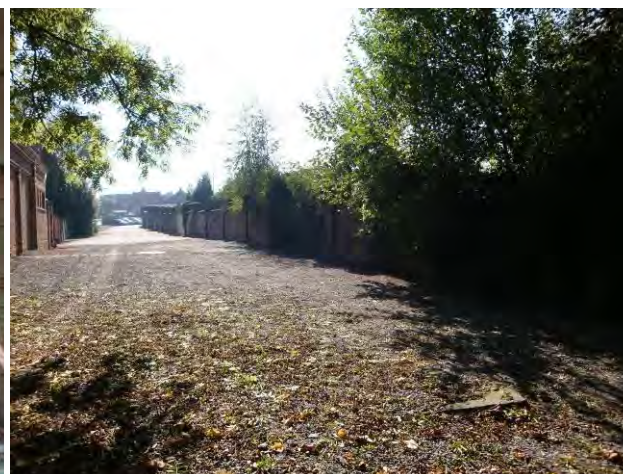
Afbeelding 24: Zicht op site vanuit fietsdoorsteek
